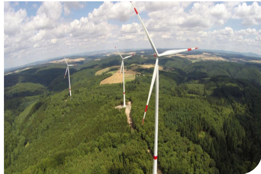
Hohenstein, Hessen (9,2 MW)
